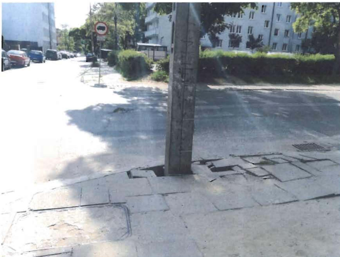
Zdj.10 Widok latarni betonowej zlokalizowanej na skrzyżowaniu ulicy Przędzalnianej i ulicy Częstochowskiej, jej lokalizacja względem przejścia dla pieszych oraz lokalizacja studni kablowej względem latarni
