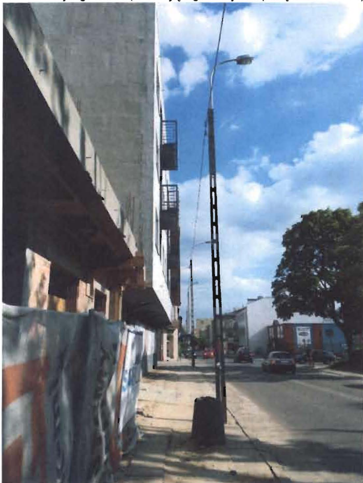
Zdj. 13 Widok pokazujący odległość napowietrznej sieci energetycznej względem balkonów budynku na ul. Przędzalnianej 82
