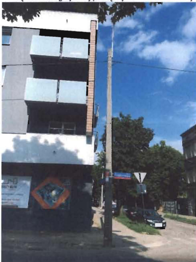
Zdj.9 Usytuowania latarni oraz sieci energetycznej względem nowego powstałego budynku na skrzyżowaniu ulicy Przędzalnianej i ulicy Częstochowskiej
