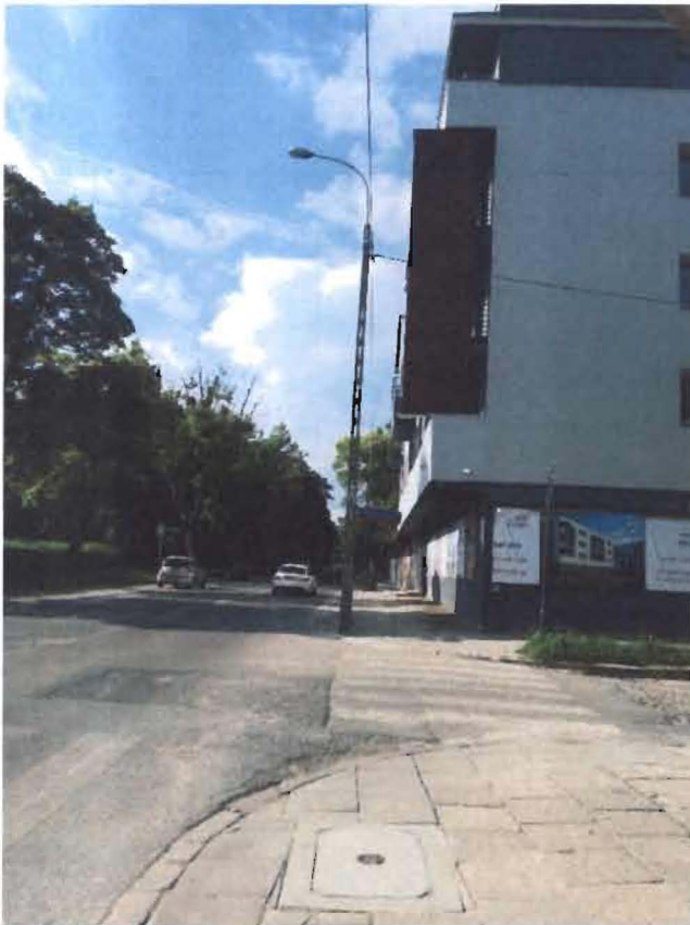
Zdj.8 Widok studni kablowej przy latarni przy kamienicy przy ul. Przędzalnianej 84 oraz widok rozciągającej się sieci energetycznej pomiędzy latarniami w bliskiej odległości od kolejnej posesji przy ul. Przędzalnianej 82
