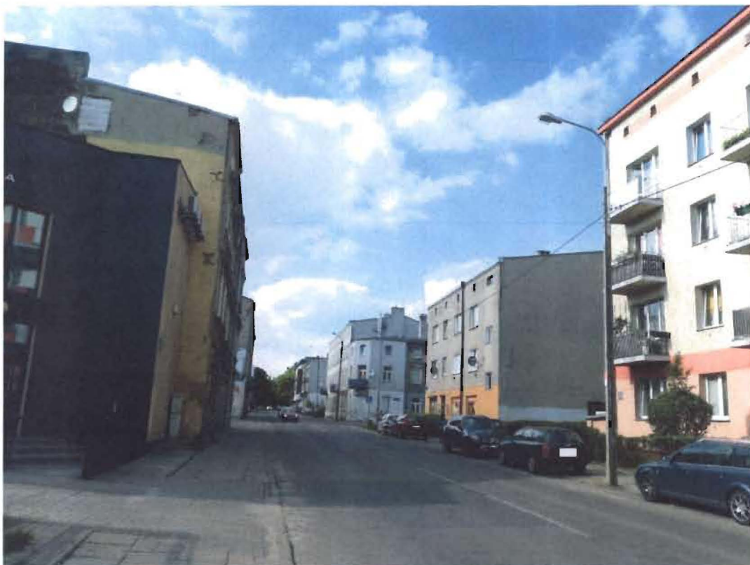
Zdj.5 Widok ul. Przędzalnianej z napowietrzną linią energetyczną zasilającą latanie.
