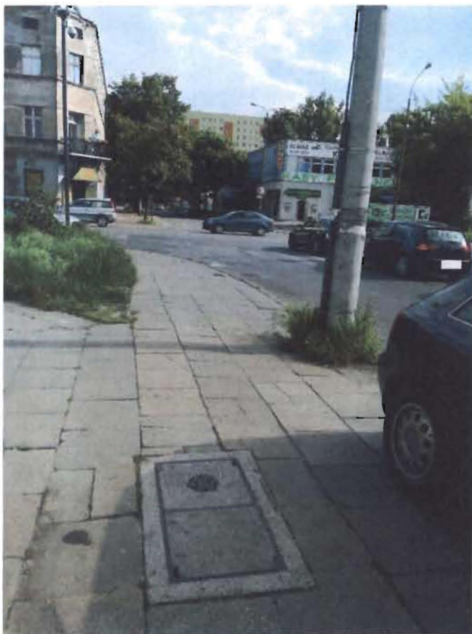
Zdj.3 Widok studni telekomunikacyjnej w bliskiej odległości od pierwszej latarni
