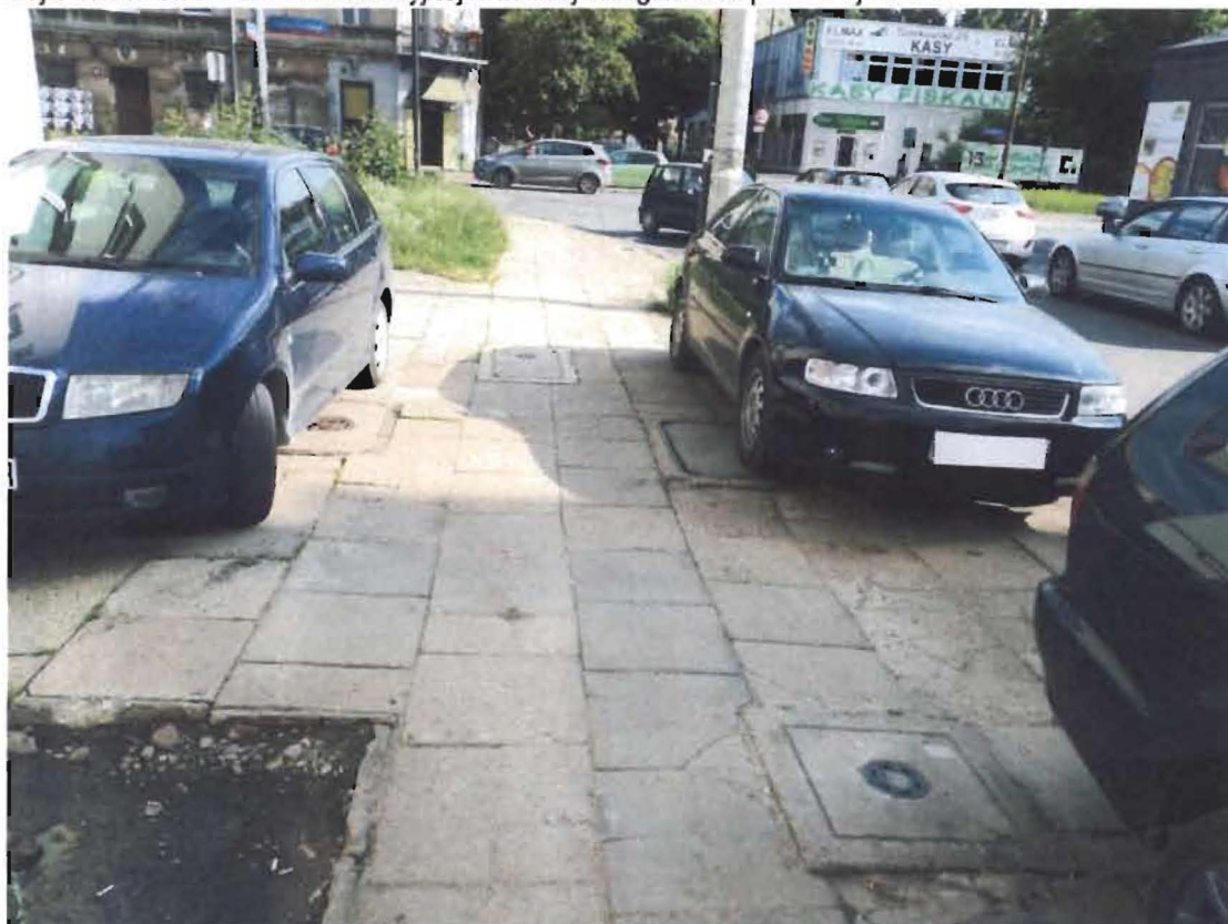
Zdj.4 Widok kolejnych 3 studni telekomunikacyjnych, kablowych w bliskiej odległości od pierwszej latarni
