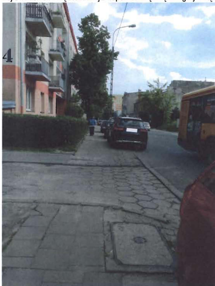
Zdj.6 Na trasie latarni w bliskich odległościach od betonowych słupów latarni zlokalizowane są studnie telekomunikacyjne.
