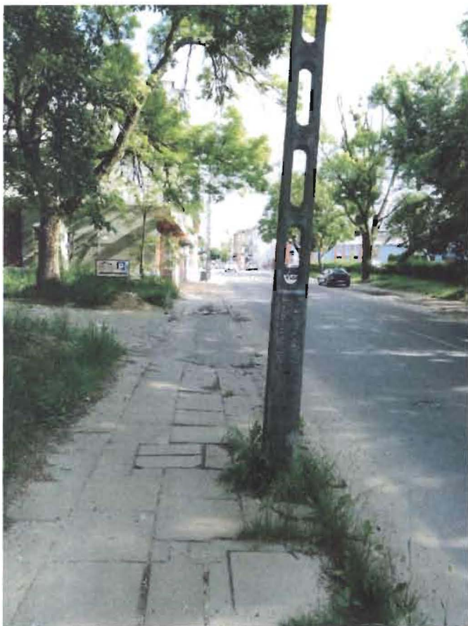
Zdj.14 Usytuowanie kolejnego słupa betonowego latarni względem studni kablowej ( 12 z 13 latarni )
