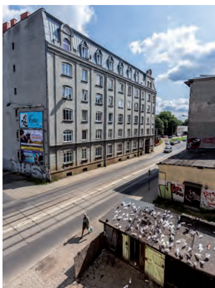
Widok na kamienicę przy ul. Franciszkańskiej 29
